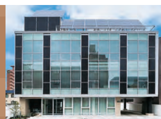
屋上、ガラス面、西側壁面に太陽光パネルを計176枚設置
