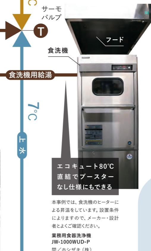
本事例では、食洗機のヒーターによる昇温を行っています。設置条件によりますので、メーカー・設計者とよくご確認ください。
