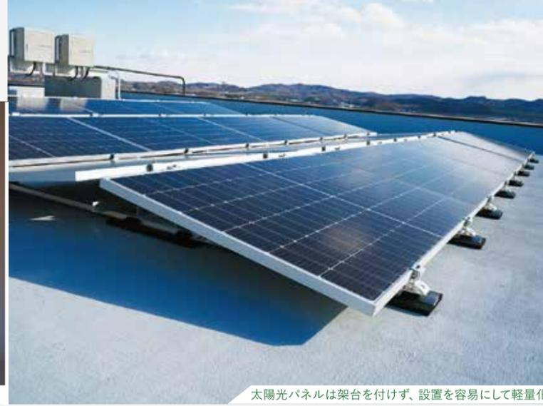
太陽光パネルは架台を付けず、設置を容易にして軽量化
