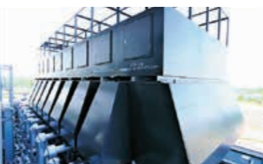
空冷式ヒートポンプチラー 暖房・冷房に利用
