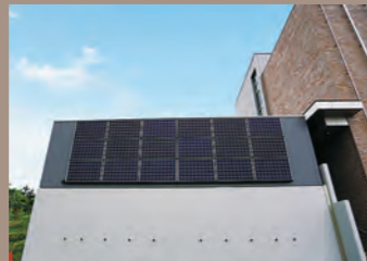
太陽光パネルは町民の目に入りやすいように南側壁面に設置
