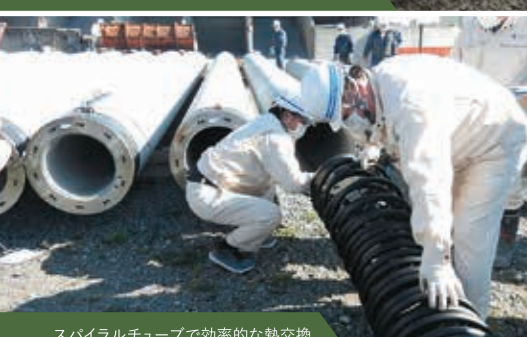
基礎杭兼用の地中熱交換器によりコスト低減
