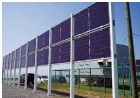
直立式太陽光パネル：容量 16.56kW (460W×36枚)
