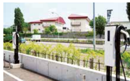
駐車場にEV充電器を2台設置
