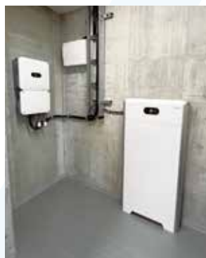
太陽光発電の余剰分を蓄える蓄電池万が一に備えて電力を確保
